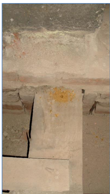
Obr.č. 39 – ST 61/vnitřní strana
