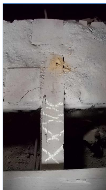
Obr.č. 56 – ST 164/vnitřní strana
