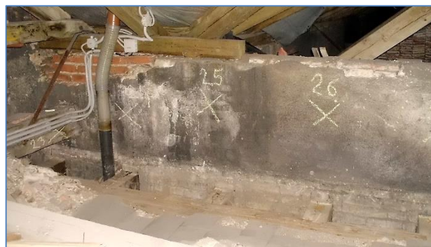
Obr.č. 61 – B3 celkový pohled na stropní trámy ST 23 – ST 28
