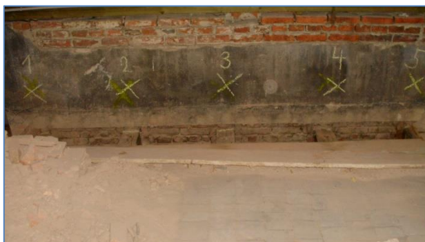
Obr.č. 1 – celkový pohled na stropní trámy 1-5
