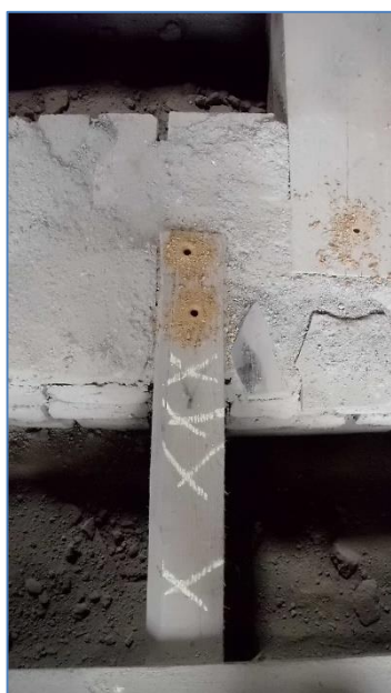
Obr.č. 57 – ST 165/vnitřní strana
