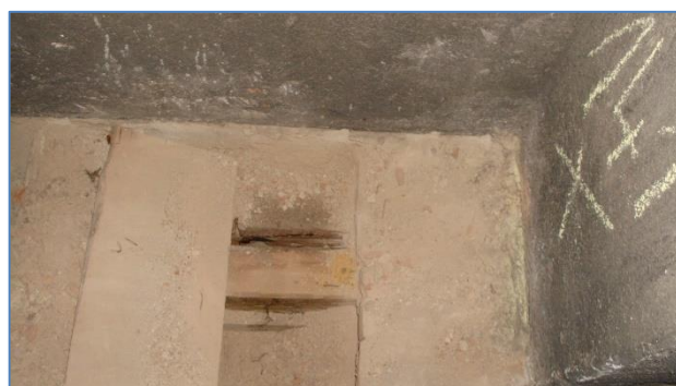
Obr.č. 50 - ST 141/vnitřní strana
